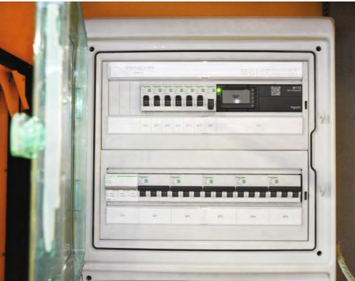
Конструктивно системы управления состоят из металлического или пластикового щита, включающего программируемый контроллер и элементы силовой защиты, а также из сопутствующих элементов автоматизации, позволяющих отслеживать те или иные параметры (датчики, терmostаты, реле и т.д.).
